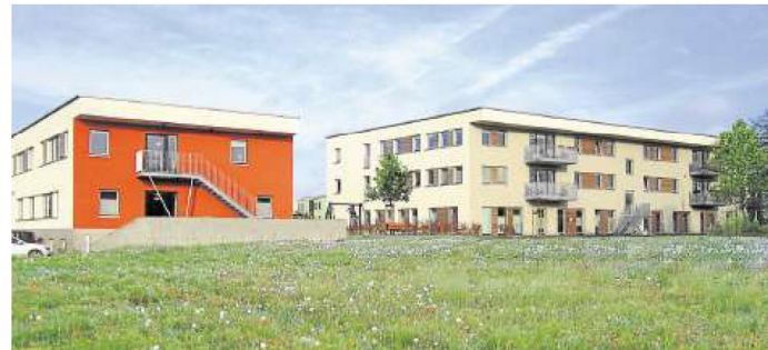
Das Sprachheilzentrum und die Agnes-Neuhaus-Schule in der Adolph-Kolping-Straße (Bild). Darüber hinaus können das Anwenderzentrum Medizintechnik in der Guttleichstraße sowie das Gebäude in der Henselstraße 7, in dem die Evangelische Studentengemeinde ansässig ist, in Gießen besichtigt werden.
